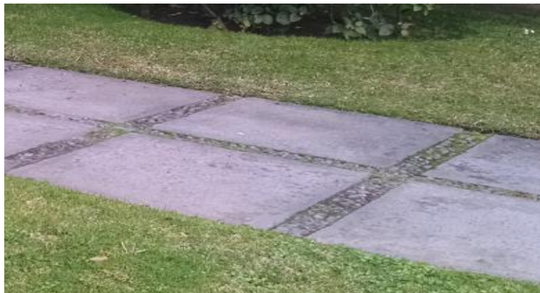
Figura 5.7: Pastelones de hormigón 50x50cm. [Fuente: Elaboración Propia].
