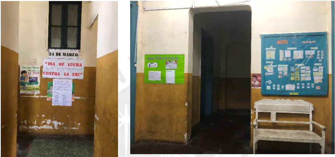
Fotografía tomada por la autora el 13/05/19; observamos las paredes de ingreso al área de ESPCT así como algunas paredes de la Sala de Espera, con recursos comunicacionales diseñados por el equipo técnico.
