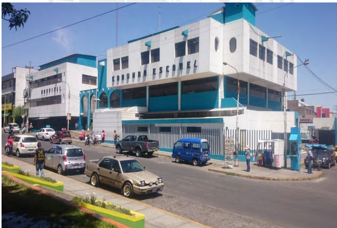
Foto 4. Hospital I Edmundo Escomel
