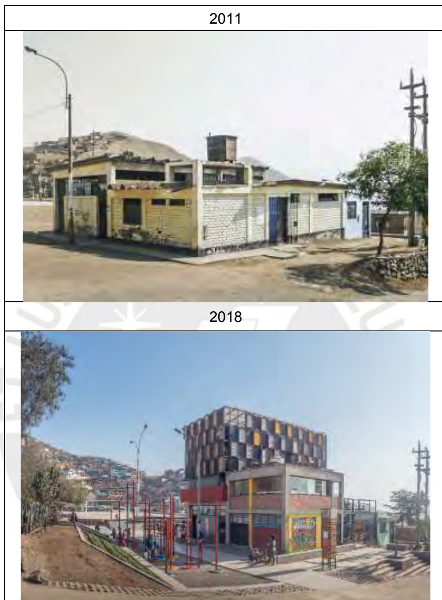
Figura 5: Local del Comedor San Martín del Once antes de la remodelación y Centro Cultural del Comedor San Martín del Once luego de la remodelación.
