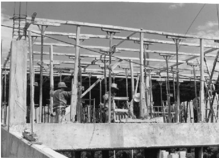
Encofrado de columnas de sección cuadrada con paneles de madera maciza. Los marcos, aros o anillos son metálicos con cuñas de acero para ajuste.
