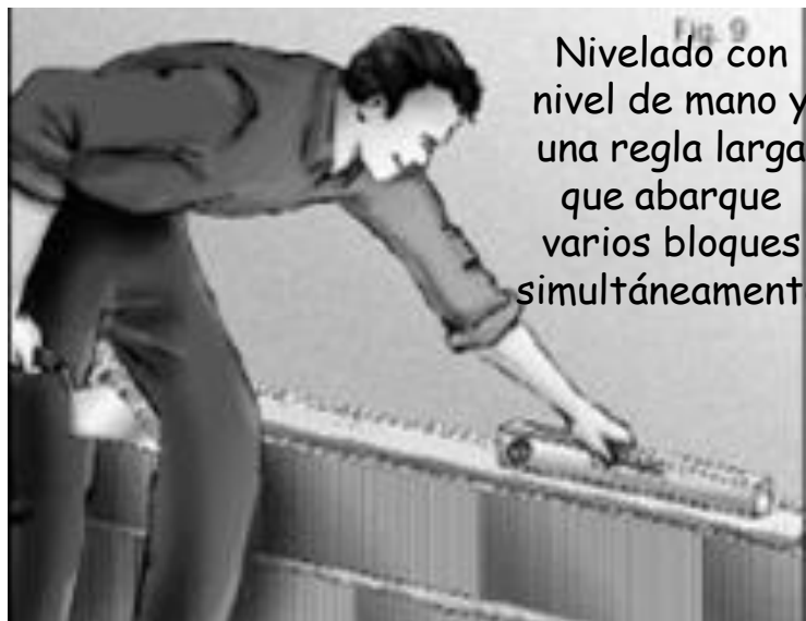
Aplomado con nivel de mano y una regla larga que abarque varias hiladas simultáneamente
