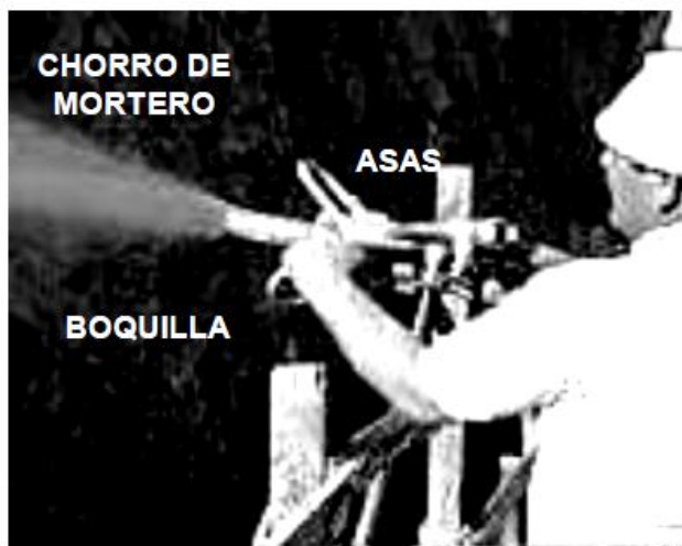
Aplicación de mortero con gutinadora
