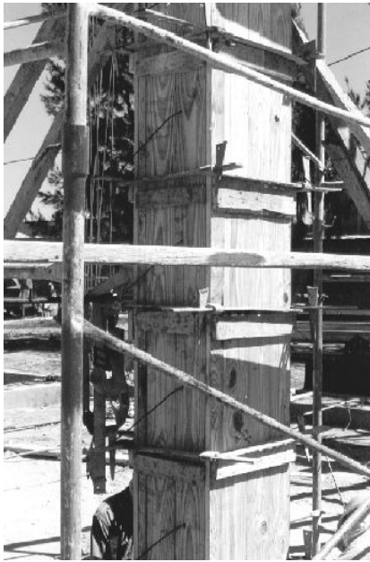
Encofrado de columnas de sección cuadrada con paneles de madera maciza, y de sección circular con moldes metálicos modulares
