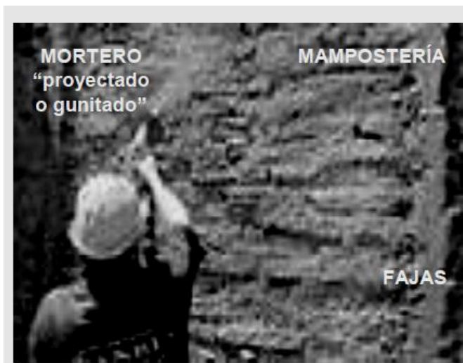
Gutinadora de mortero (15 m 3 /hora) equivale aproximadamente a 500m 2 de revoque/hora
