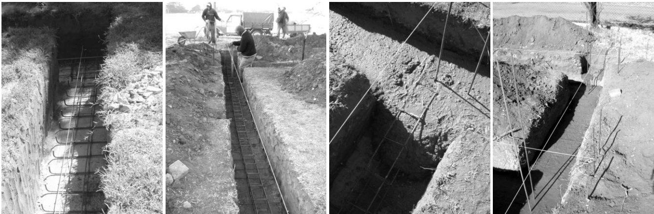
FOTOS: ARQ C. S. GUZZETTI- FUNDACIONES SUPERFICIALES- ZAPATAS CORRIDAS O PLANTILLAS
