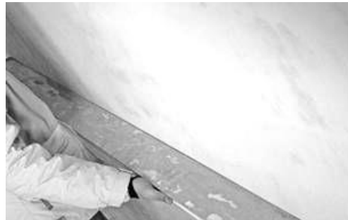
ALISADO y NIVELADO de mortero de yeso previamente gunitado o proyectado
