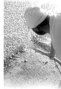
GUNITADO o PROYECTADO de mortero de yeso
