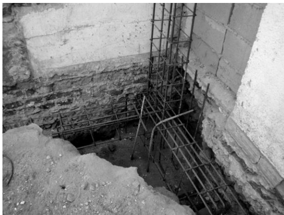
FOTOS: ARQ C. S. GUZZETTI- ARMADURA DE CABEZAL PARA PILOTES- FUNDACION PROFUNDA
