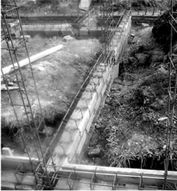
Encadenados horizontales
