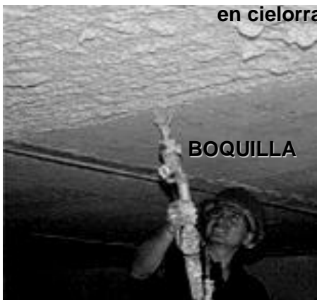
GUNITADORA de mortero (10 m 3 / hora) equivale aprox. A 300 m 2 de revoque / hora
