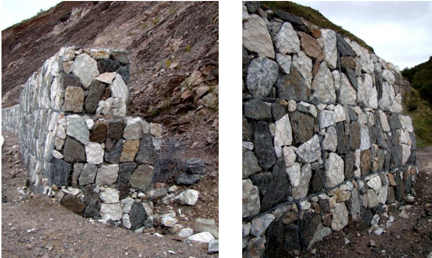
Gaviones contruidos sobre el Camino del Cuadrado, Provincia de Córdoba
