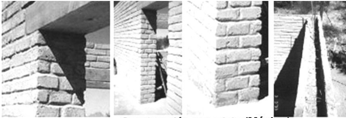
Construcción con adobe(México)
