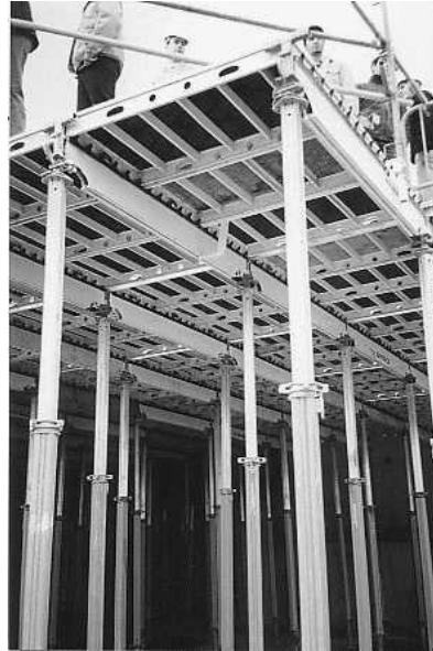
Encofrados metálicos modulares para losas
