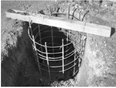
FOTOS: ARQ C. S. GUZZETTI- FUNDACIONES PROFUNDAS- PILOTES- POZOS
