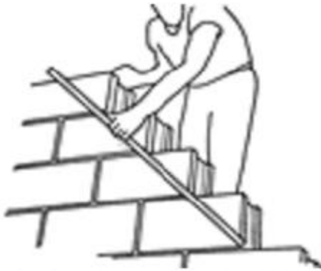
Control de desplazamiento de hiladas
