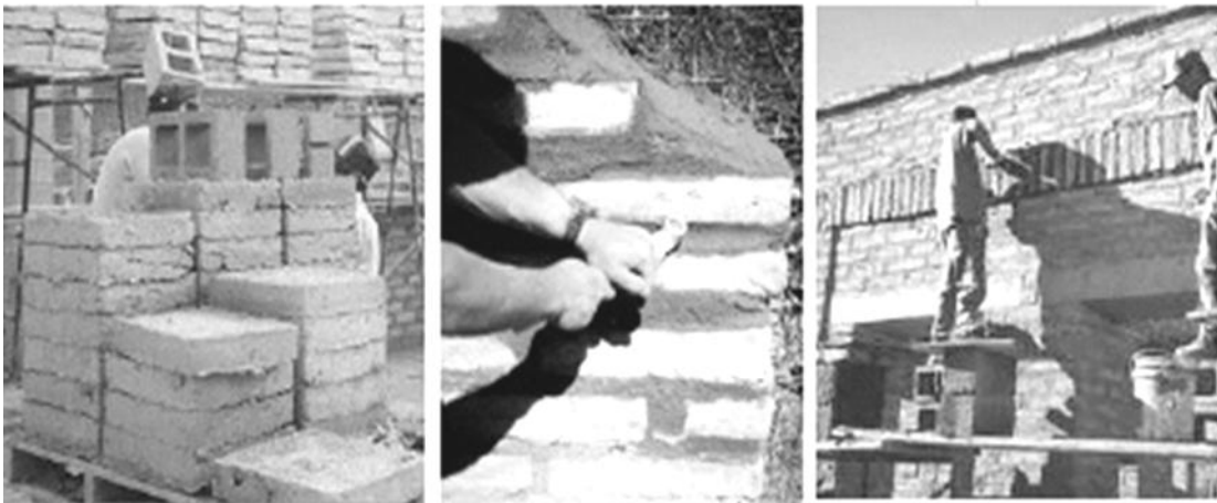
Adobe estabilizado con agregado de pequeñas cantidades de arena, cal y cemento.
