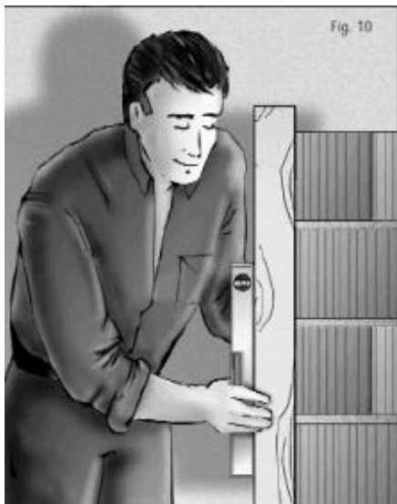
Aplomado con nivel de mano y una regla larga que abarque varias hiladas simultáneamente
