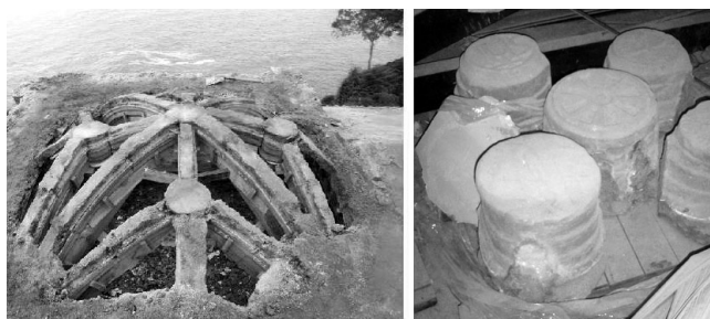
Figura 5. Desmontaje de la bóveda y detalle de las claves recuperadas.
