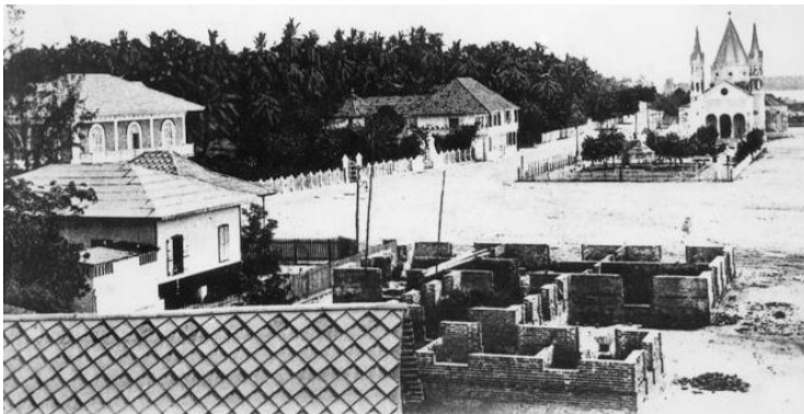
Imagen 6 Vista desde las murallas del barrio El Cabrero en construcción, 1915. Fuente: El Universal, 2011
