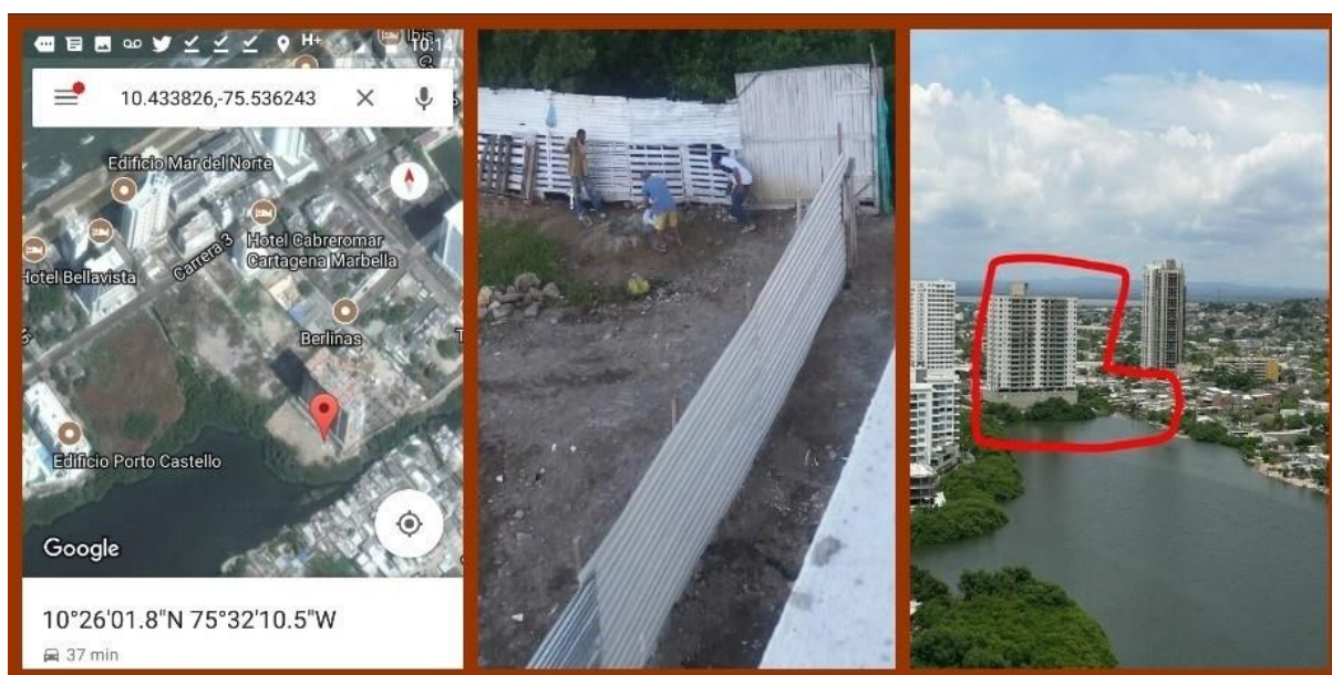
Imagen 29 Construcción atípica em el barrio El Cabrero, violando la regulación sobre construcciones en áreas de protección, en este caso, el manglar. Fuente: Revista Metro, 2018
