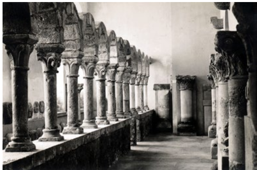
FIG. 2 Museu Machado de Castro: claustro da igreja medieval de São João de Almedina reconstituído in situ (c. 1938). © Museu Nacional Machado de Castro.
