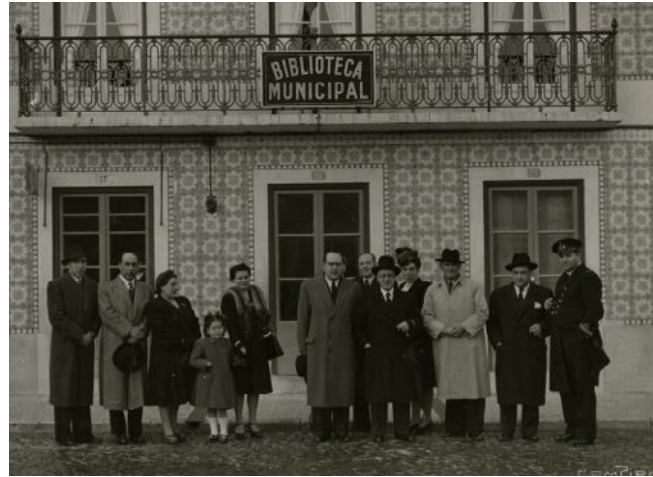
FIG. 2 Fachada do Edifício do Museu- Biblioteca Vidal Baptista. Autor desconhecido, 1947-1951. © Museu Municipal de Vila Franca de Xira.
