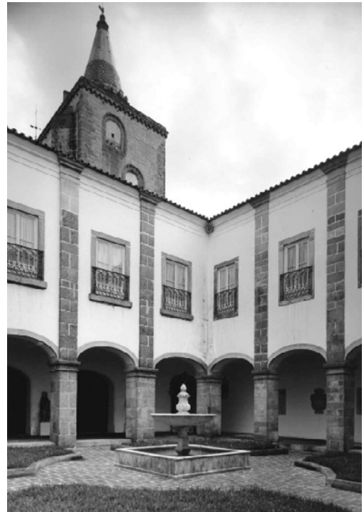
FIG. 2 Claustro do Museu Regional de Évora após renovação na década de 1940. Ó FMS, FMAC, Pt. 05524.000.259
