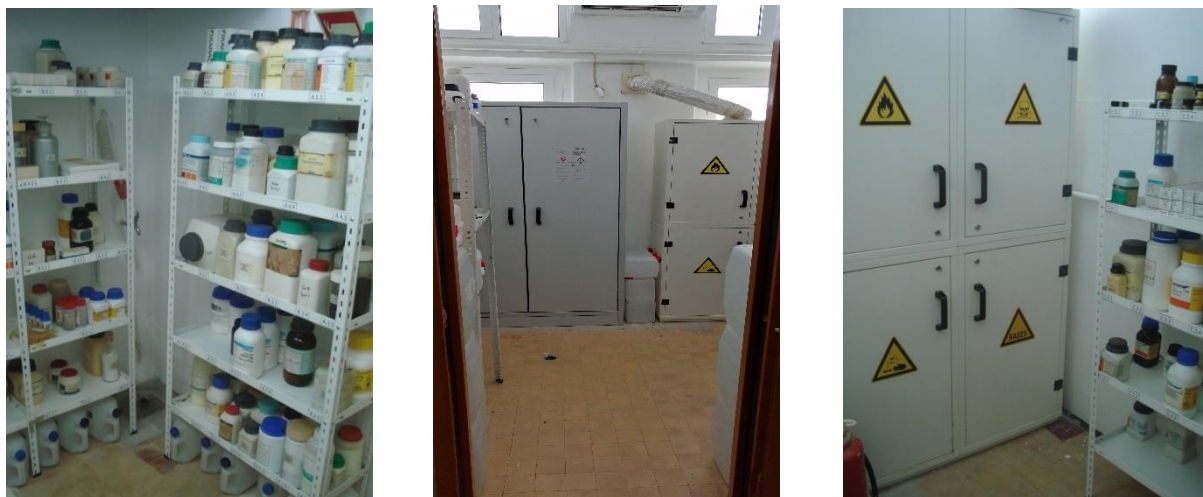
Figuras 3.2, 3.3 e 3.4 Sala dos produtos químicos.
