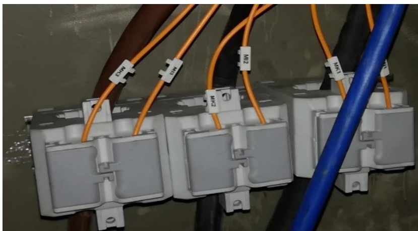
Figura 87. Ligação dos TI's AM13
