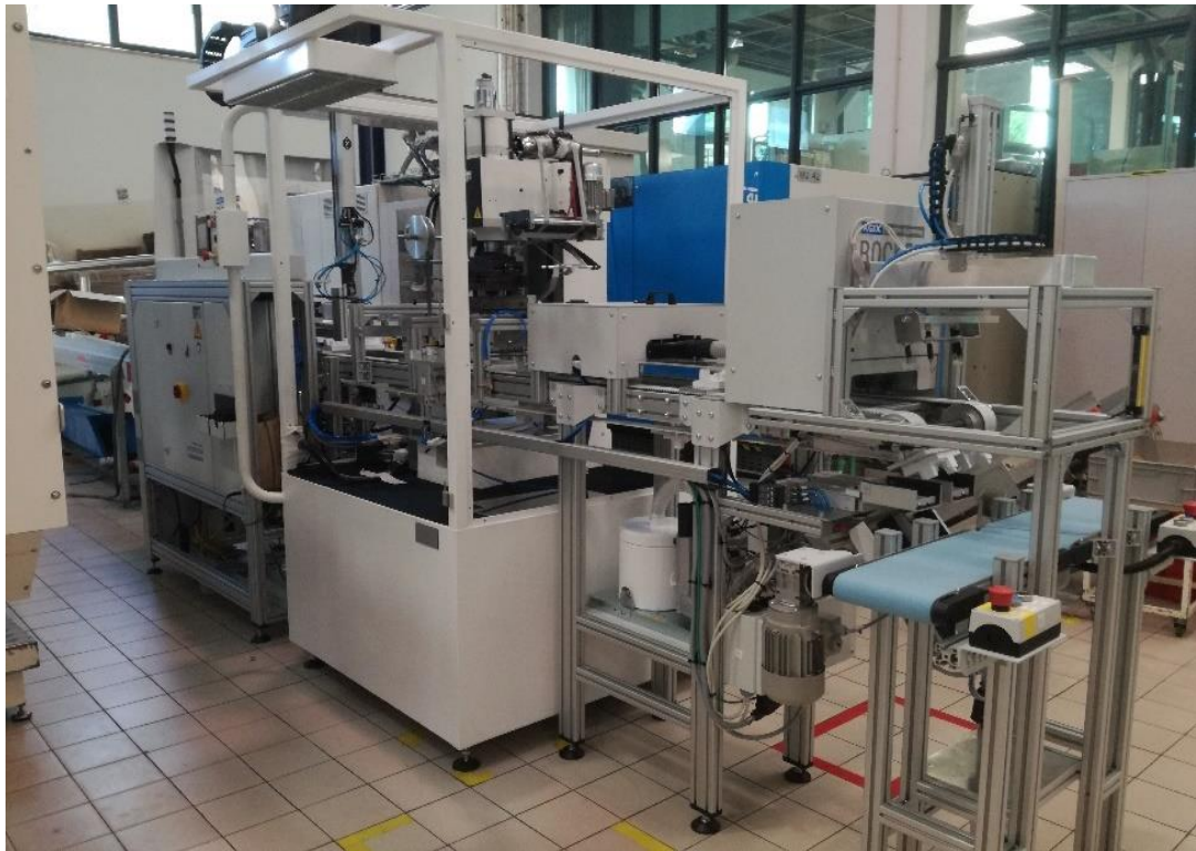
Figura 102. AG35-ROCKER - Instalação final
