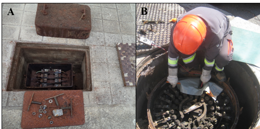
Figure 3.21: Caixa de derivação: A) caixa de corte de 2 entradas B) caixa de derivação de 4 saídas
