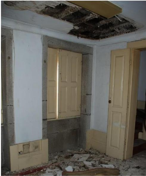
**Figura 39** - Interior do edifício do posto telegráfico, durante as obras de reabilitação realizadas em 2009. Visível o vigamento de madeira do teto, as portas, janelas e lambrins de madeira.
