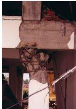
Fig. 12 – Viga forte pilar fraco [25].
