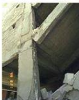
Fig. 7 – Vigas com comportamento não dúctil [20]
