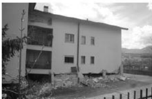
Fig. 11 – Colapso de um edifício em L'Aquila, Itália, 2009 devido ao soft storey , [24].
