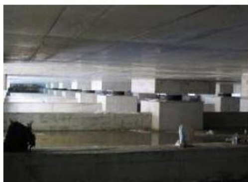
Fig. 16 – Dispositivos de Isolamento de Base no Hospital da Luz, Lisboa, [32].
