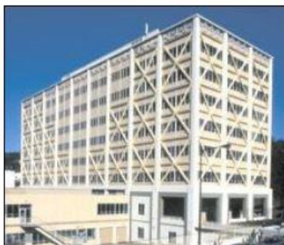
Fig. 15 – Solução de reforço com contraventamentos metálicos, [31]
