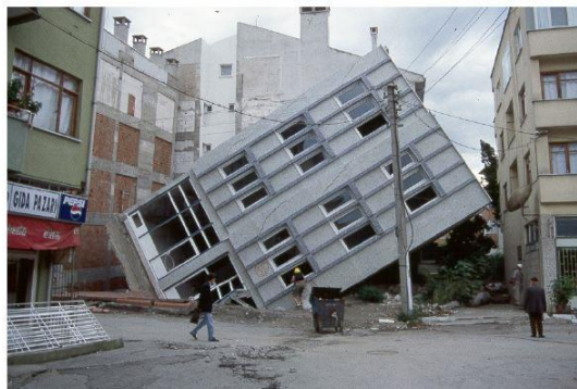
Fig. 13 – Assentamento vertical e rotacional da estrutura devido ao efeito da liquefação do solo [27].
