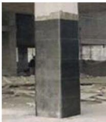
Fig. 21 – Encamisamento parcial de um pilar com FRP's, [26].
