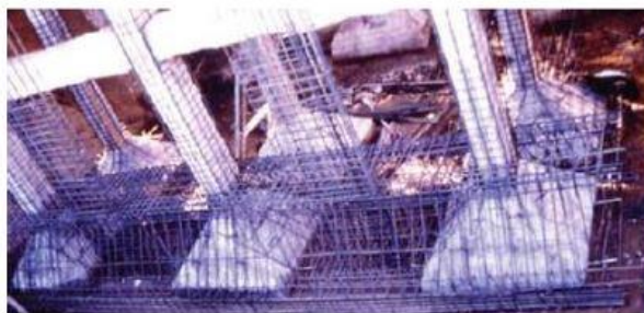
Fig. 14 – Sapatas dos pilares vizinhos, integradas nas vigas de fundação da nova parede de betão armado, [28].
