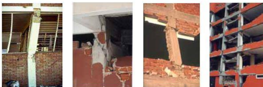
Fig. 10 – Mecanismos tipo short column, [19].
