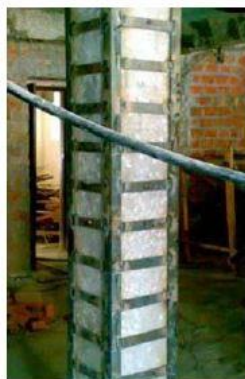
Fig. 19 – Encamisamento de um pilar com elementos metálicos, [26].
