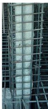
Fig. 18 – Encamisamento de um pilar com betão armado, [26].
