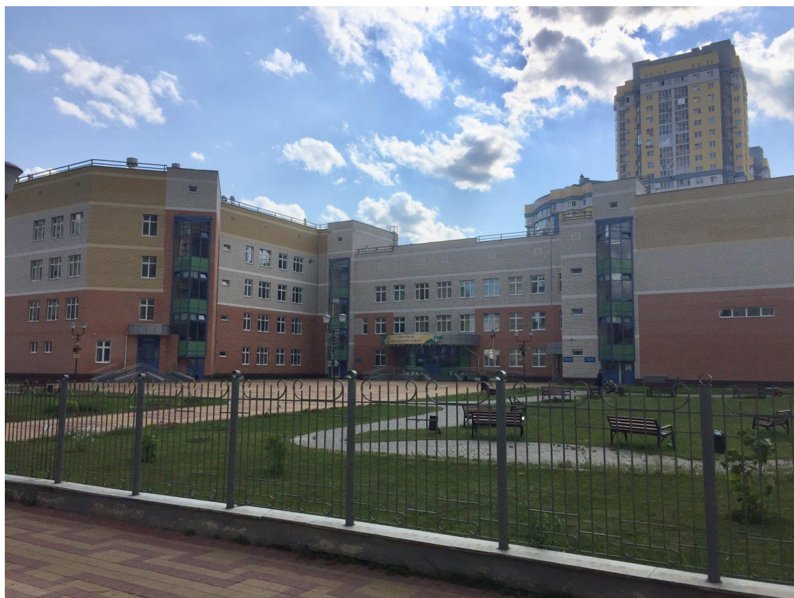
Рис. 15. Общий вид школьного здания
