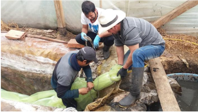
Participante del programa ayudando a instalar un biodigestor en una finca en Sesquilé, Cundinamarca. Foto: Fomento Ganadero-Alquería.
