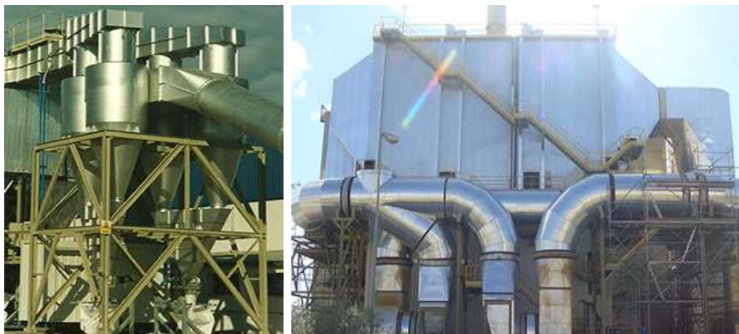
Figura 10.5. Conjunt de ciclons i filtre electroestàtic (Font: DEFISA)
