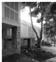
Figs. [93], [94] y [95]. De izquierda a derecha, apartamentos Cala Viña (1961-1962), Xipre (1960-1962) y Madrid (1961-1962) de Antonio Bonet Castellana y Josep Puig Torné. Puede observarse como la adición de una terraza al proyecto permitía articular el alojamiento destinado al reposo con su medio más inmediato: el mar, el sol y la playa.
