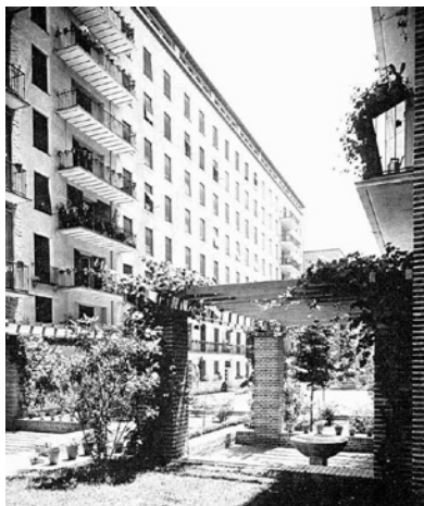
Fig. [201]. Patio interior de la Casa de las Flores de Secundino Zuazo, construida entre 1930-1932. Quizá uno de los conjuntos más representativos de la modernidad racionalista en la década de los años treinta, en el que puede apreciarse un interés por acercarse a los principios higienistas de la época buscando una vivienda más funcional, ventilada e iluminada que ciertamente tiene la habilidad de incorporarse a la imagen urbana de su entorno.
