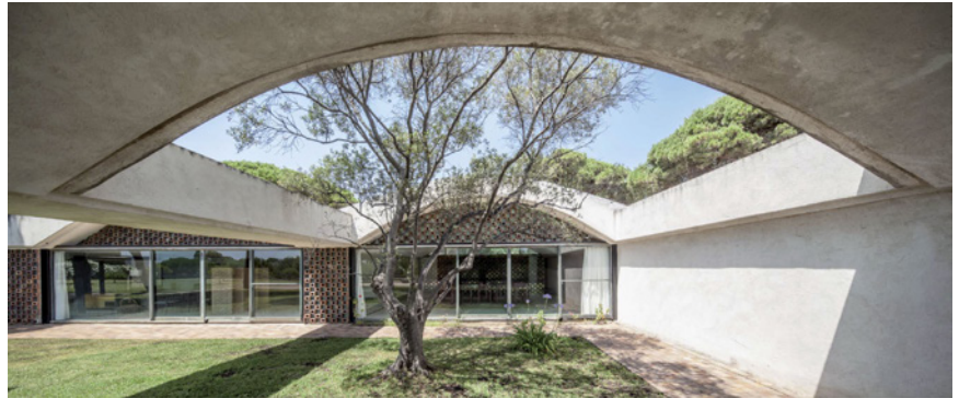
Figs. [348] y [349]. Arriba, fotografía de las alfombras de «césped» en el interior de la sala. Abajo, fotografía de las «alfombras» de césped en el exterior de la casa. Fotografías de Adrià Goula tomadas en 2015.
