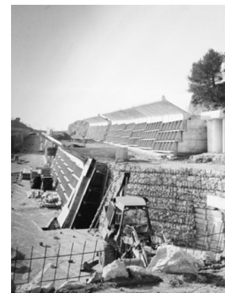
Fig. [353]. Fotografías tomadas por Esther Rovira durante la obra del Parc Cementiri Nou d'Igualada. Como en el Land Art, una mínima manipulación permite un cambio de sentido en los acontecimientos previsibles generando una atmósfera de tensión suficiente para provocar una reflexión al público visitante.
