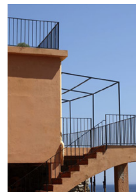
Fig. [22]. Casa Bastida antes de la rehabilitación de Bosch-Capdeferro.
