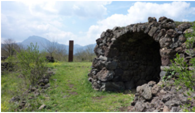
Fig. [326]. Barraca enfrentada a monolito de acero en tanto que sistema de señalización en uno de los claros recuperados del pasado.
