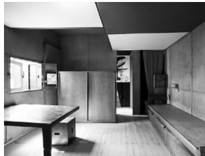
Figs. [99] y [100]. De izquierda a derecha, detalles del montaje de la «Caseta desmontable para playa» (1932) propuesta por los miembros del Grupo Este del GATEPAC, y detalle interior de la construcción en seco de Le Cabanon (1952) de Le Corbusier. A pesar del carácter efímero de los dos proyectos, no pasa desapercibido como en el caso de Le Cabanon —obra realmente llevada a la práctica— hay además una clara voluntad de encajar en el paisaje la arquitectura a través de ventanas que fijan sus detalles desde el interior y del uso de materiales próximos al lugar desde el exterior.
