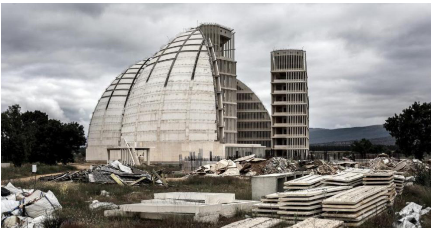
Fig. [113]. Cúpulas de la energía de la definitivamente inacabada Ciudad del Medio Ambiente (2008-2014) ubicada en Garray (Soria). La propuesta de una nueva ciudad de dos magníficos arquitectos como lo es Emilio Tuñón (1959-) y lo era Luis Mansilla (1959-2012), que paradójicamente ajenos precisamente al medio, que construye un paisaje en este caso ubicado en Castilla y León, pretendían integrar un nuevo núcleo urbano en un entorno natural protegido, confiando únicamente el éxito del equilibrio arquitectura-medio al uso de una tecnología muchas veces llamada autosuficiente.
