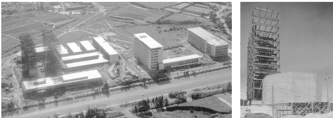
Figura 4. Edificio H en construcción. Fuente: Guillermo Lusa Monforte.
