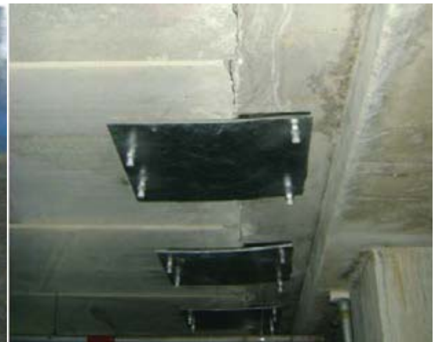
Figura 3. Vista inferior del junt de dilatació del sostre de la planta -1, un cop reparat (Font: pròpia)
