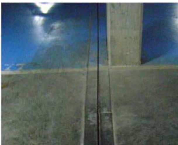
Figura 2. Vista superior del junt de dilatació del sostre de la planta -2 (Font: pròpia)
