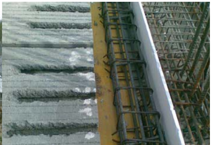
Figura 11. Vista del junt de dilatació en el procés de muntatge dels passadors i l'armat (Font: constructora)
