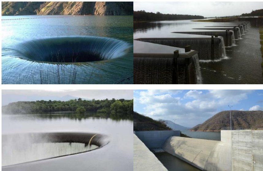
Figura 2.1 Tipos de vertederos según su geometría en planta.
