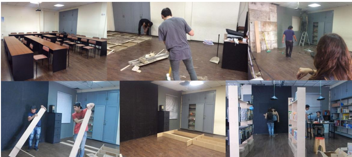
Construcción del set de Nano Lab
