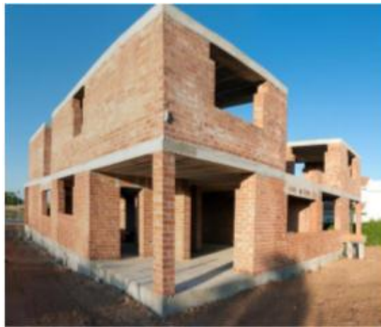
Figura 1. Edificación de MNR en construcción (tomado de Çitiloğlu, 2016)
