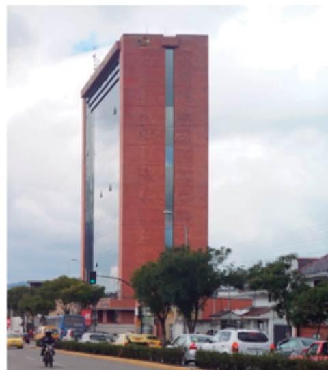
Figura 79. Cámara de Industrias. Fuente: Propia
