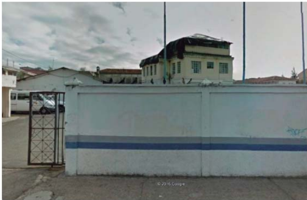
Figura 83. Edificación Jefatura de Tránsito 2015. Fuente: Google Earth.
