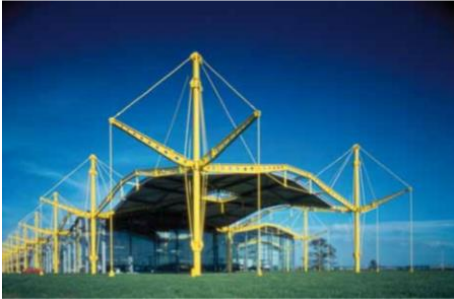
Figura 3.7: Fabrica de Reanult. Nave atirantada. [4]
