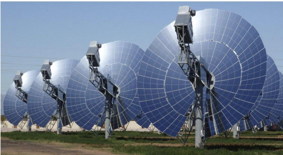
Figura 9. Sistema de discos parabólicos [9]
