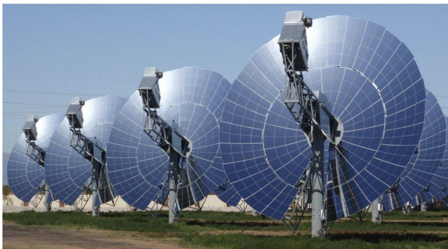
Ilustración 44: Central solar de discos parabólicos [34]
