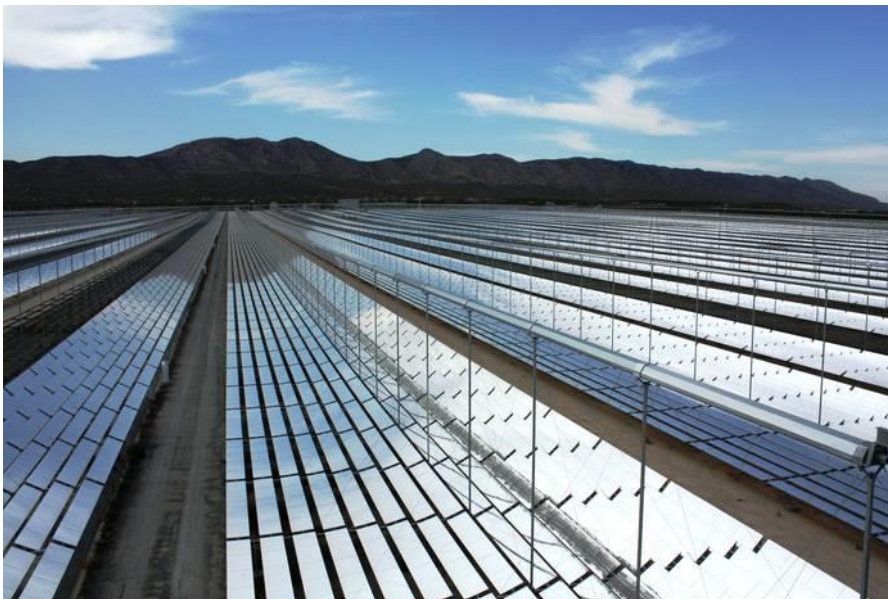
Ilustración 41: Planta termosolar lineal Fresnel Puerto Errado 2 [31]
