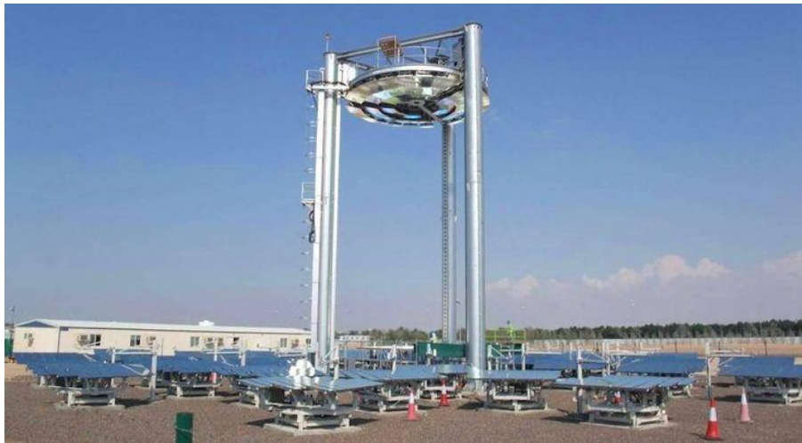
Ilustración 46: Concentrador termosolar Beam-Down [37]
