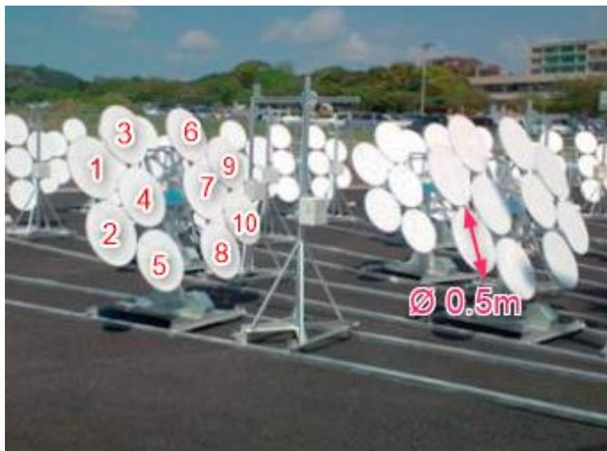
Ilustración 62: Heliostatos sistema BD Miyazaki. Fuente: Propia
