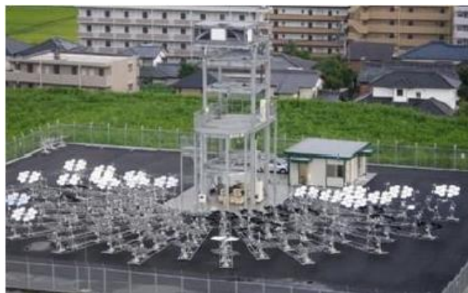
Ilustración 15: Nuevo sistema de concentración solar construido en Miyazaki [7, p.2]
