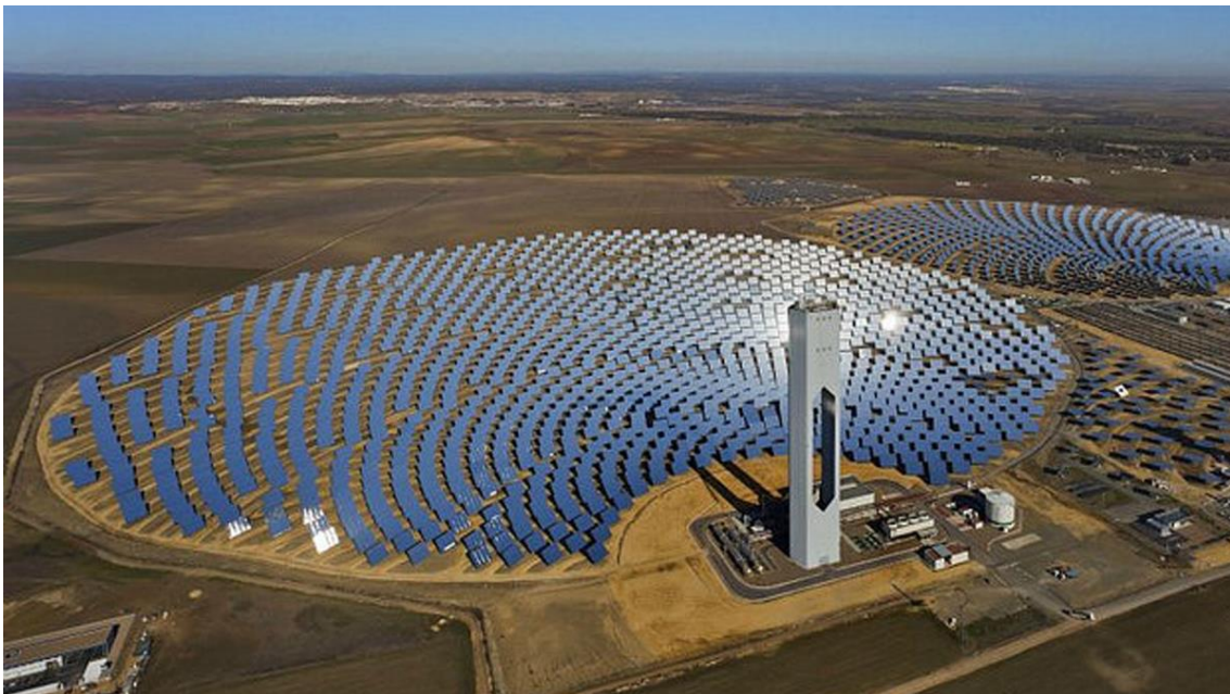
Ilustración 33: Impacto visual de un campo de heliostatos [22]
