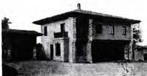
ANSERO (SANTANDER).—CASA PROPIEDAD DEL SR. FALSA.—GARAJE Y CASA DEL GUARDA. Arq. E. F. Quintanilla.
