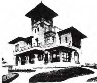
SANTANDER.—CASA DE D. A. HERRERA. Arq.: R. Lora del Norte.
