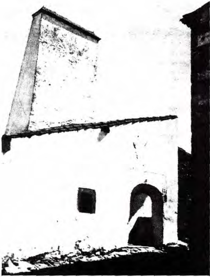
1. — LIENZO BLANCO, ARCO Y CHIMENEA DESCOMUNAL. UN CONDENSADO DE ARQUITECTURA POPULAR EXTREMEÑA (SALVATIERRA DE SANTIAGO).
