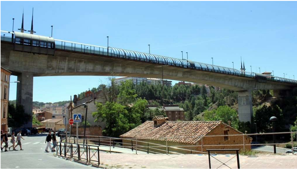
Figura 5. Viaducto Nuevo de Teruel [7].
