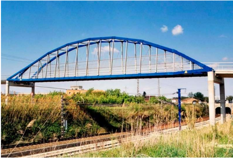
Figura 4. Primera pasarela peatonal fabricada en materiales compuestos en España (2000-2001) [6].
