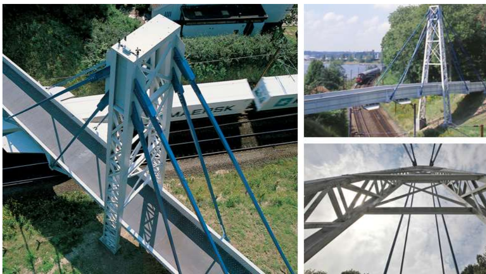
Figura 15. Pasarela en Kolding, Dinamarca [25].
