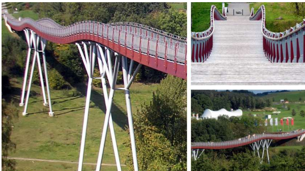
Figura 13. Puente del Dragón, Alemania [24].
