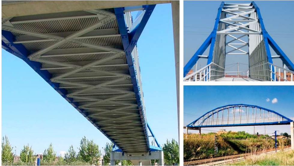
Figura 14. Pasarela peatonal en Lleida [6].
