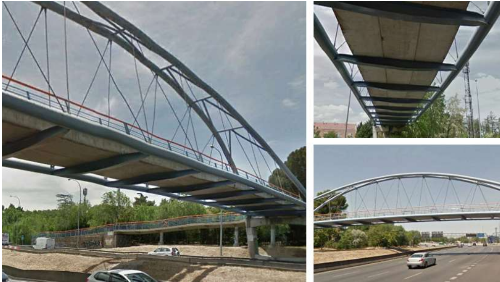
Figura 11. Pasarela sobre la A-6.
