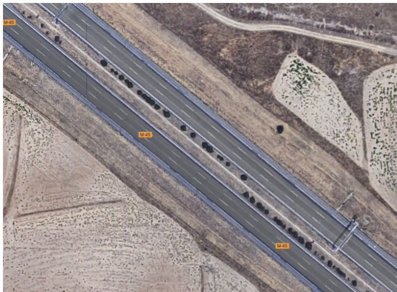
Figura 37: Foto satélite del tramo de carretera a estudio para el modelo.
