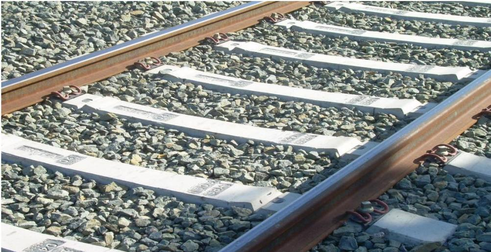
Figura 2.3. *Traviesas de una vía de ferrocarril.*
