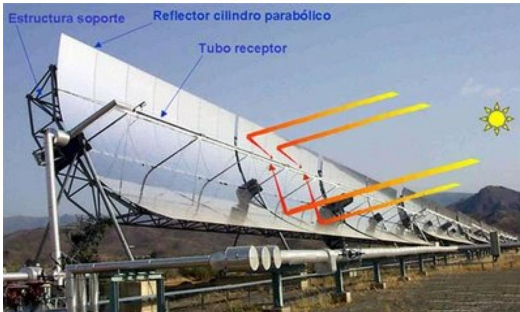
Ilustración 14: Colectores cilindro-parabólicos. Fuente [themorningstarg2.wordpress.com](http://themorningstarg2.wordpress.com)
