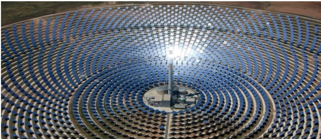
Ilustración 7: Central eléctrica termosolar con receptor central. Fuente Abengoa
