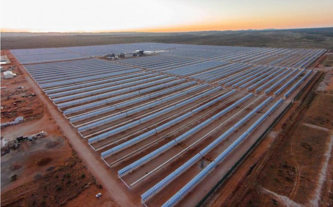
*Ilustración 15: Central termosolar con colectores cilindro-parabólicos. Fuente Imágenes Google*
