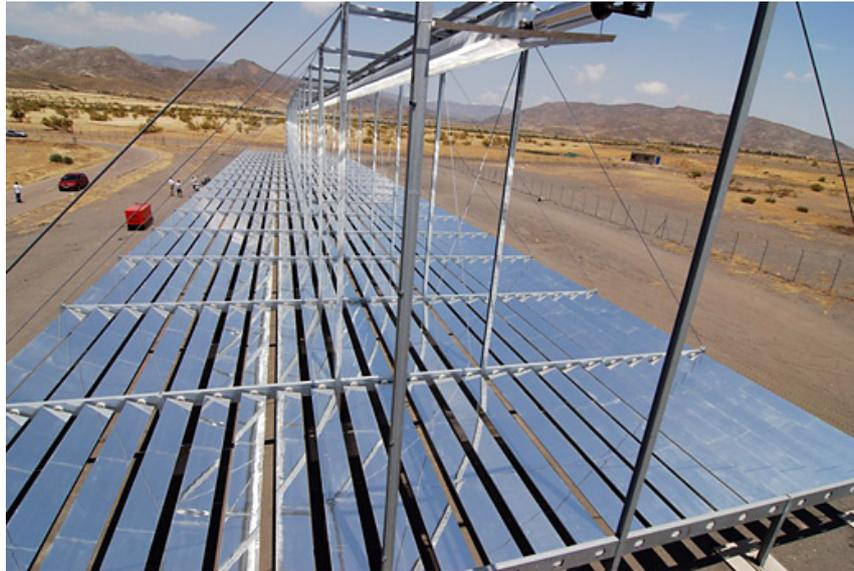
Ilustración 11: Receptores lineales Fresnel. Fuente [www.solar-energia.net](http://www.solar-energia.net)
