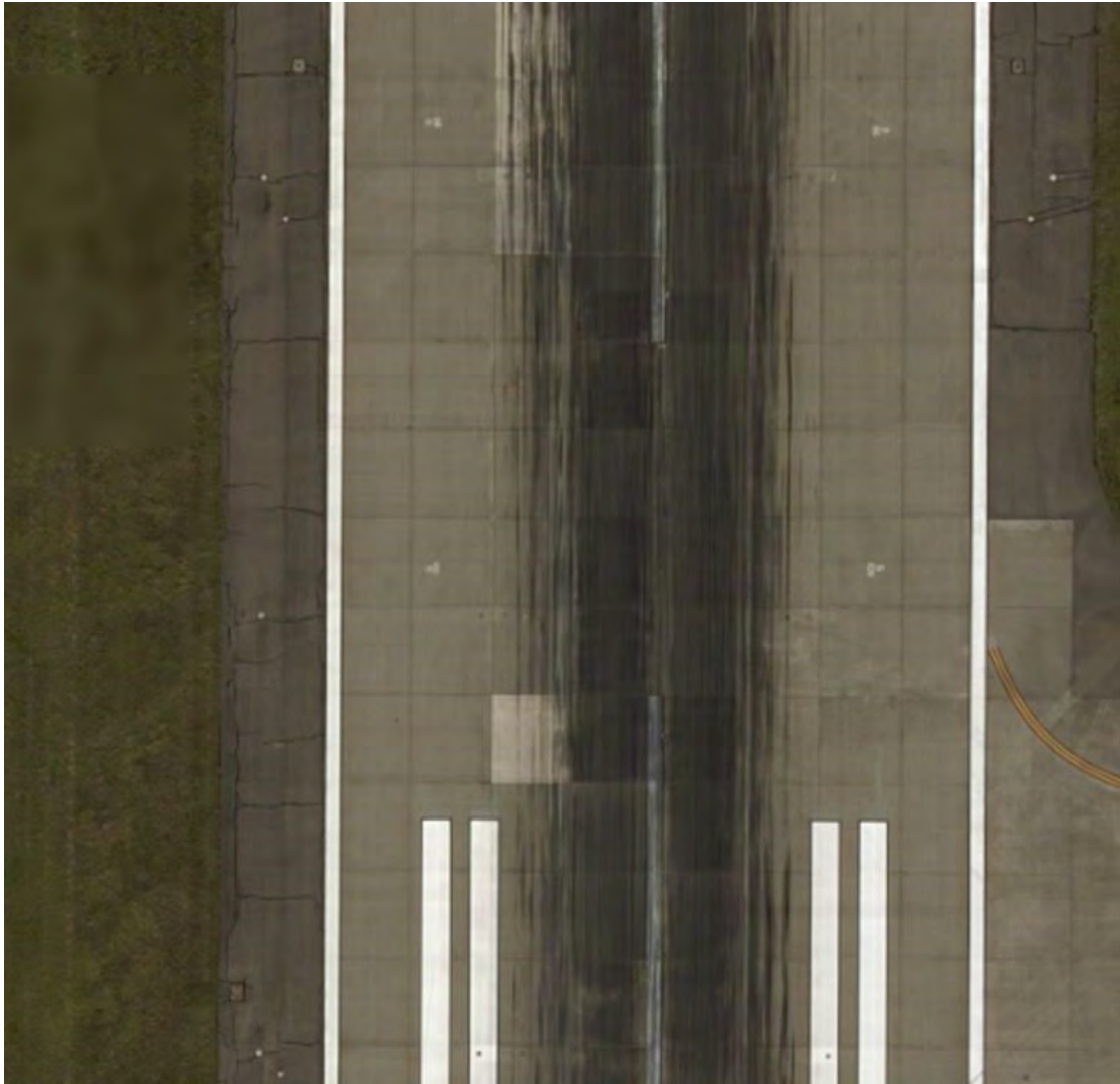
Figura 6.23: Acumulación de caucho y marcas de la pista de aterrisaje del aeropuerto de seattle
