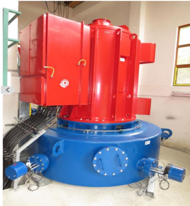
Figura 3.14 Turbina Pelton hidráulica de Siapro utilizada en una central de generación hidroeléctrica de 1 MW: Fuente: http://en.hydro-electricity.eu/
