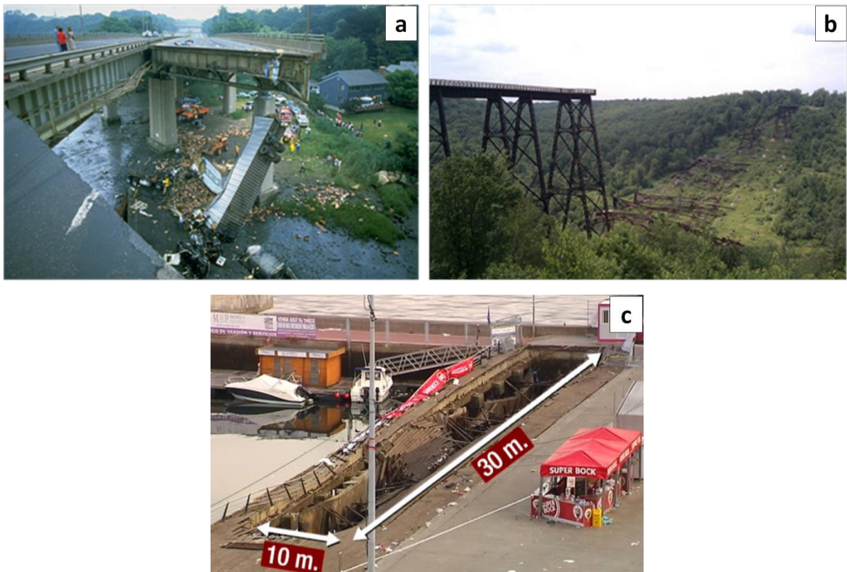
Figura 1.1. Fallos debidos a la corrosión: (a) Puente del rio Minaus, Connecticut, Estados Unidos (1983); (b) Puente Kinzua, Pensilvania, Estados Unidos (2003) [3] y (c) Muelle de Vigo, España (2018) [4] .
