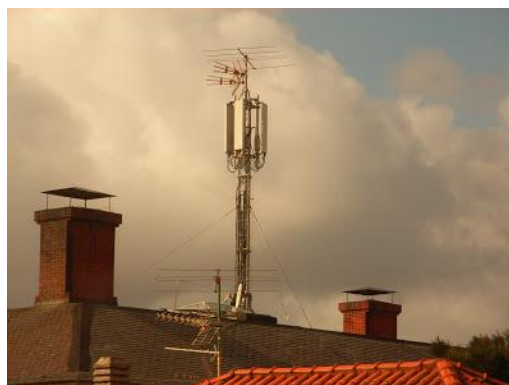
Figura 2.3 Tejado con antena colectiva. [5]
