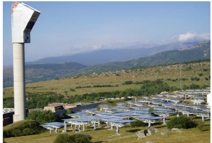
Ilustración 22. Central termosolar de torre [54]
