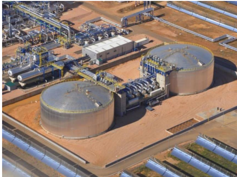
Figura 20. Tanques de almacenamiento
