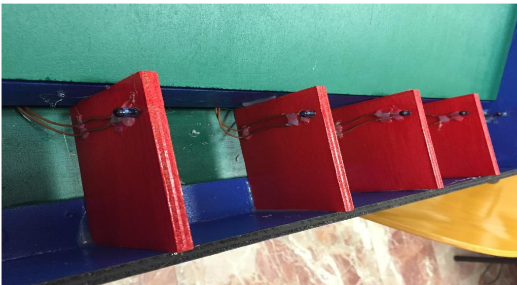
Ilustración 40. Colocación de la los led para la detección
