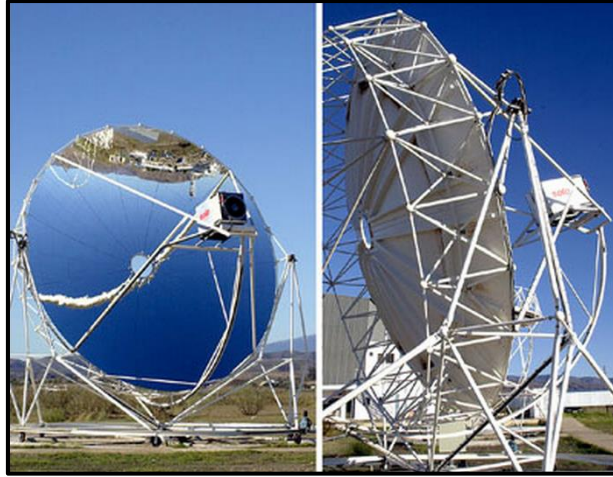
Figura 27. Vista anterior y posterior de disco parabólico EuroDISH con motor Stirling (Plataforma Solar de Almería).
