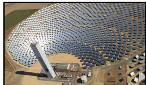
Figura 31. Configuración campo norte, vista aérea de la central solar térmica PS20 (Abeinsa :: Infraestructuras para un mundo sostenible).
