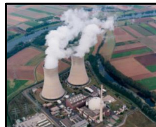
Figura 55. Torres de refrigeración (Apuntes Máquinas y Centrales Térmicas).
