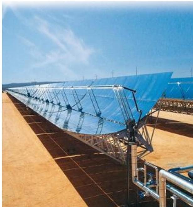
*Figura 3.1 Instalación de colectores cilindro parabólicos.*
