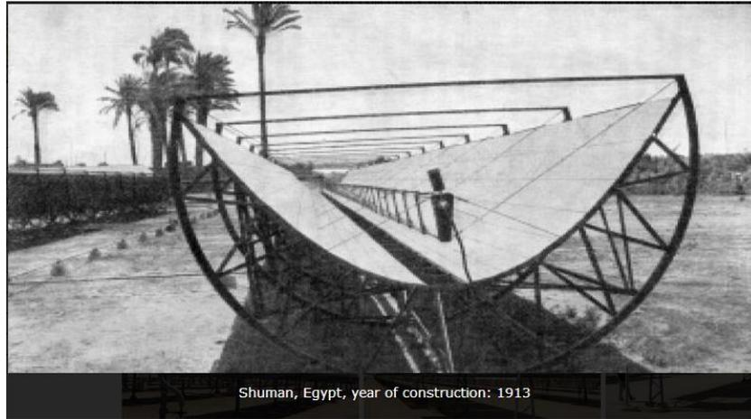
*Figura 2.1 Primera instalación de CCP's. Egipto (1913)*
