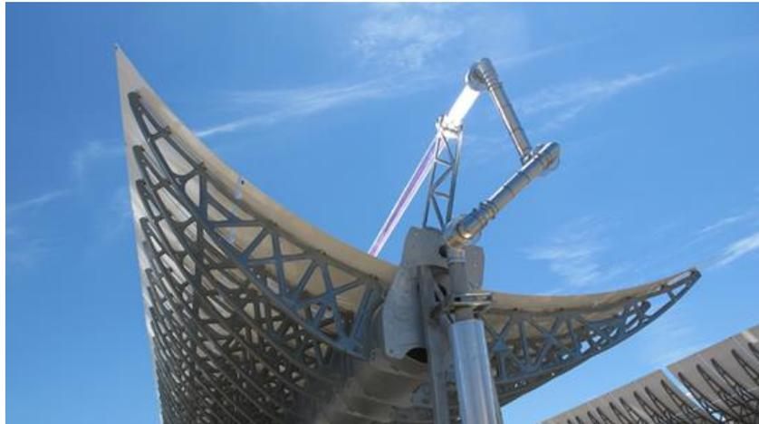
*Figura 3.9 Estructura del colector y brazos de sujeción del receptor.*
