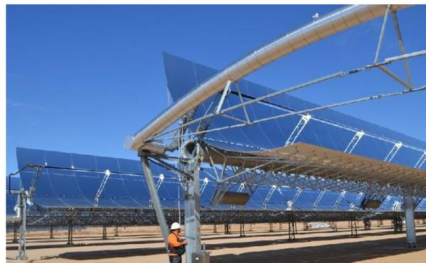
*Figura 2.4 Sistema cilindro-parabólicos.*
