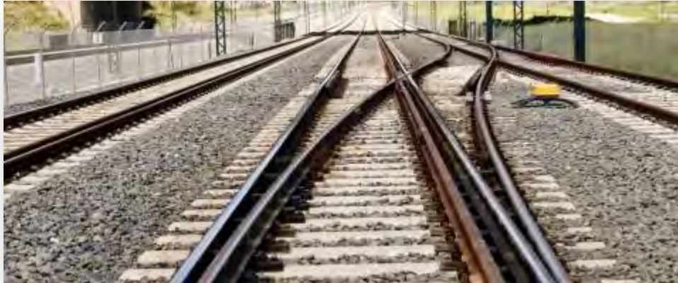
Figura 5.4. Vista de la implantación del tercer raíl.
