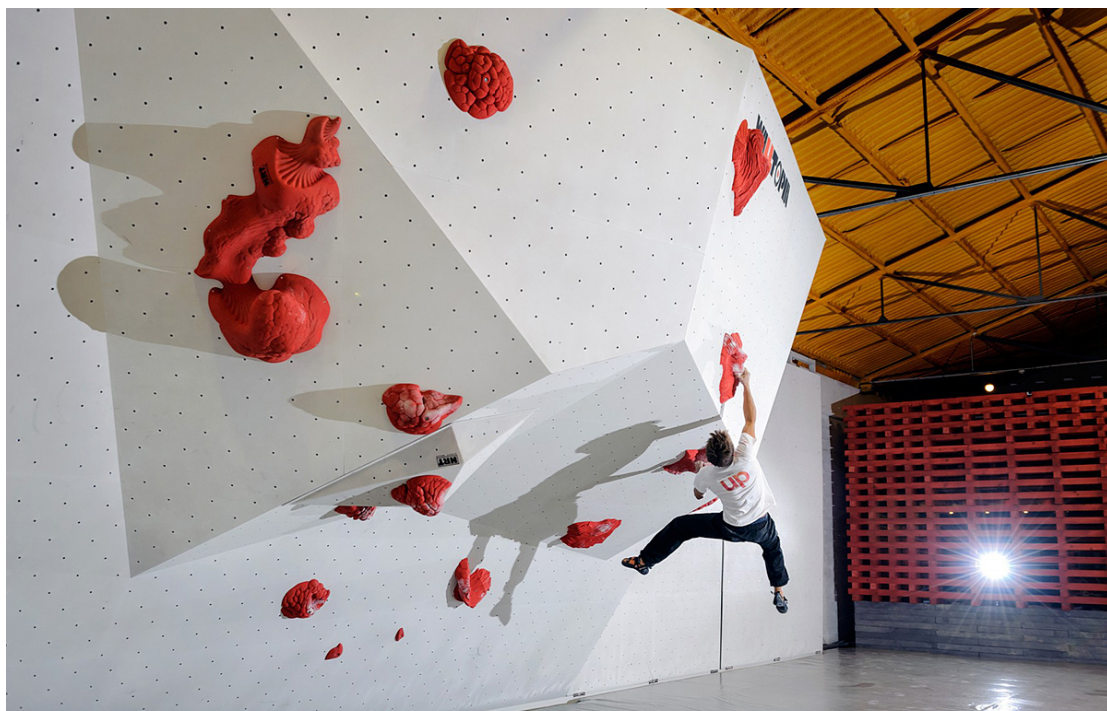
Fig. 2.3 Presas atornilladas a paneles de madera en rocódromo de boulder [21]
