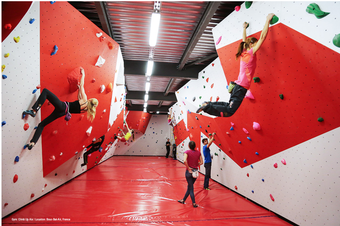
Fig. 2.2 Presas atornilladas a paneles de madera en rocódromo de boulder
