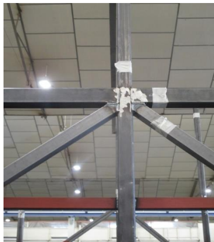
Figura 1. 14. Uniones perfiles laterales
