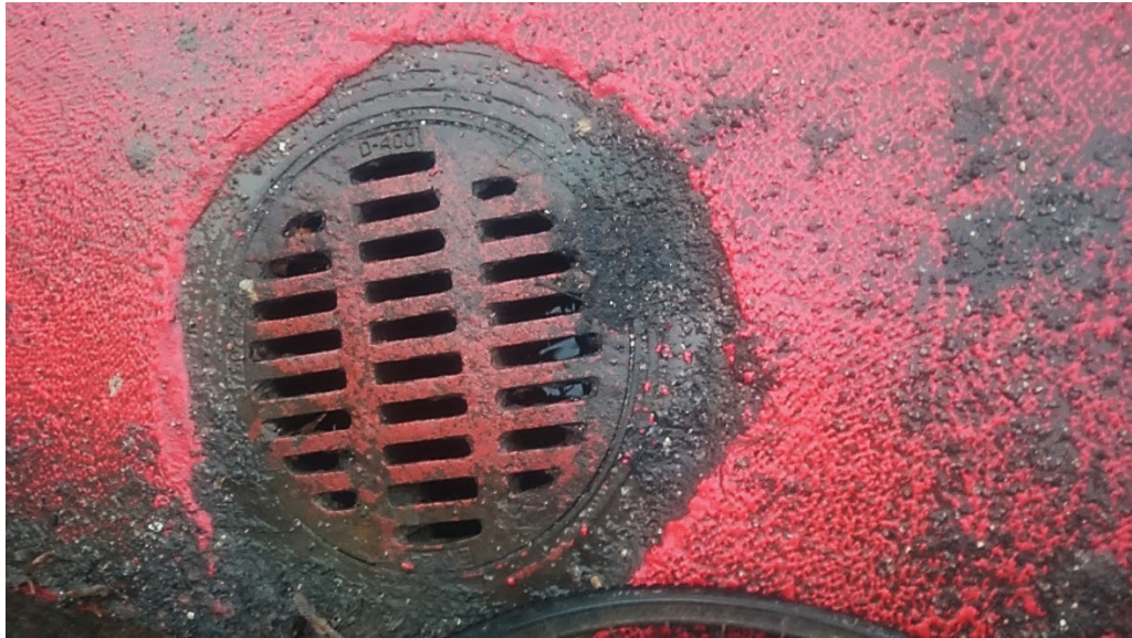
Kuva 13. Liikennealueella käytettävä pyörätien merkintämassa irtoaa ja valuu hulevesien mukana kaivoon. Kuva: Olli Hakala.
