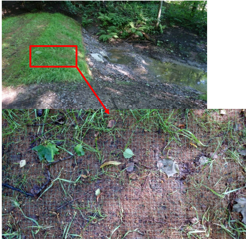
Kuva 14. Helsinkiin rakennettiin 2017 hulevesiä puhdistava ja viivytävä puisto, jonka rakenteissa käytettiin eroosi- onsuojamattoa. Maton yhtenä rakennekerroksena on valmistajan mukaan "UV-" tai "biohajoavaa" polypropeeniverk- koa. Kuva: Olli Hakala.
