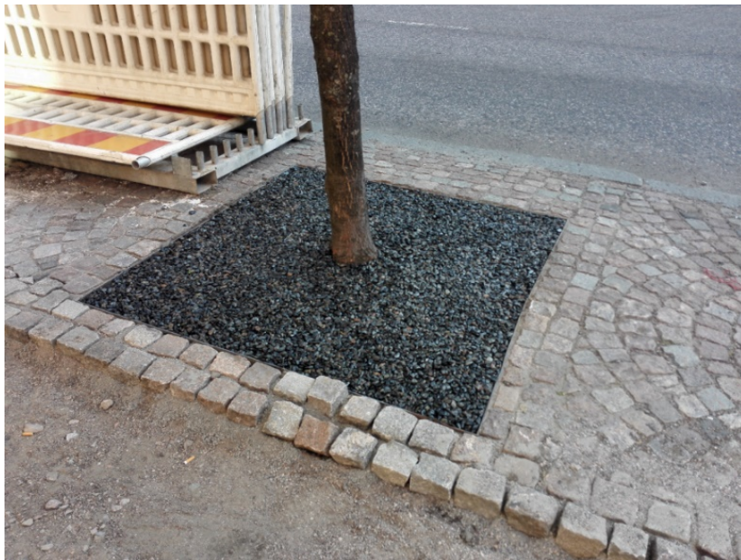
Kuva 15. Helsingissä rakennetussa kohteessa puun juuristoalueella on käytetty katetta, jossa runkoaineena on se- peli, joka on kovetettu kaksikomponenttisella epoksihartsilla. Valmistajan mukaan se soveltuu pihakäyttöön, kiveys- ten rajauksiin, käytäville ja kivisaumoihin. Kuva: Eila Sihvola.
