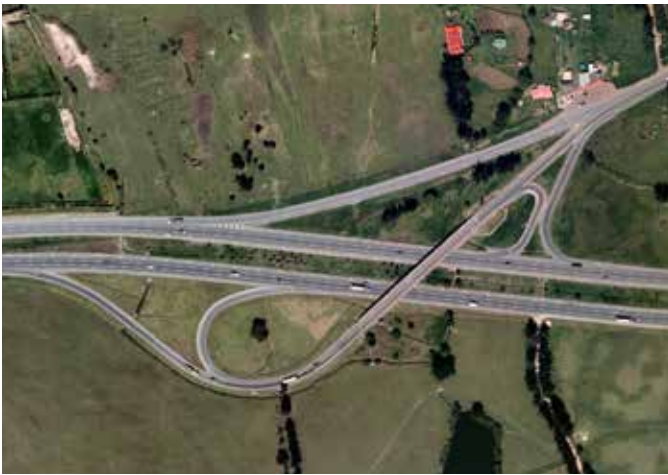
7. Puente de conexión entre la Carretera Central del Norte y el acceso a Briceño
