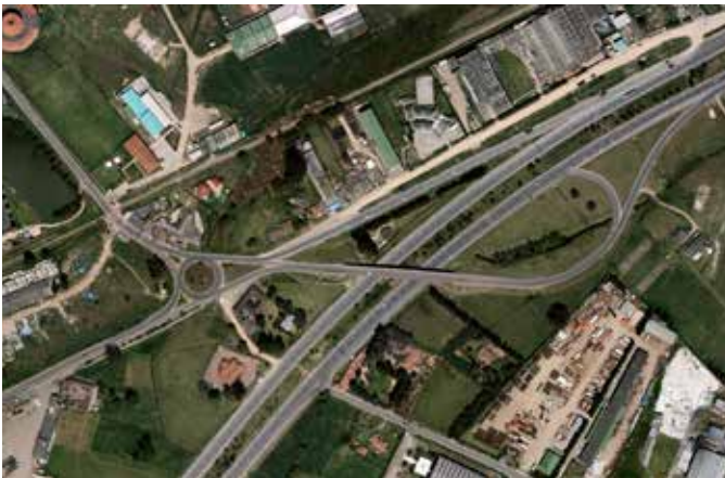
8. Puente de conexión entre la Carretera Central del Norte y el acceso a Briceño
