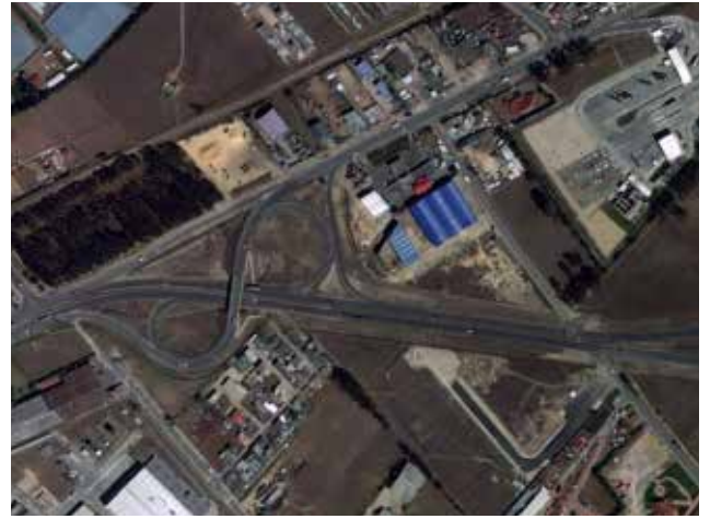
9. Puente de conexión entre la Carretera Central del Norte y el acceso a Tocancipá
