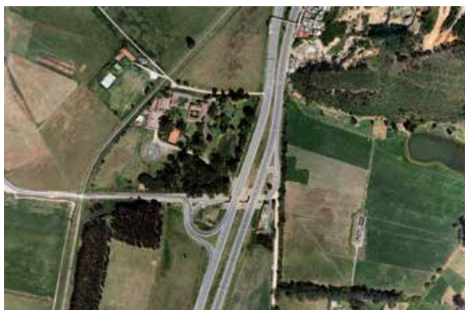
5. Puente de conexión entre la Carretera Central del Norte y via a Cajica en el sector de Hatogrande
