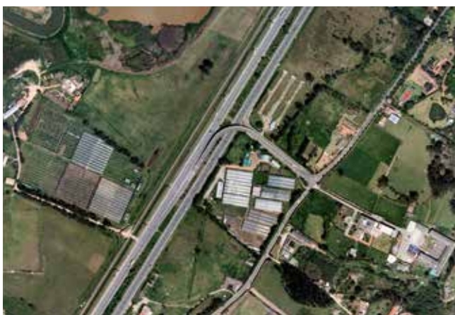
4. Puente de conexión entre la nueva y la antigua Carretera Central del Norte
