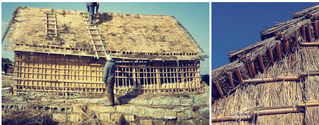
Figura 3: Baraccas sarde. Interventi di manutenzione, a sinistra; dettaglio del pacchetto di copertura, a destra (Brunetti_B., 2015)
