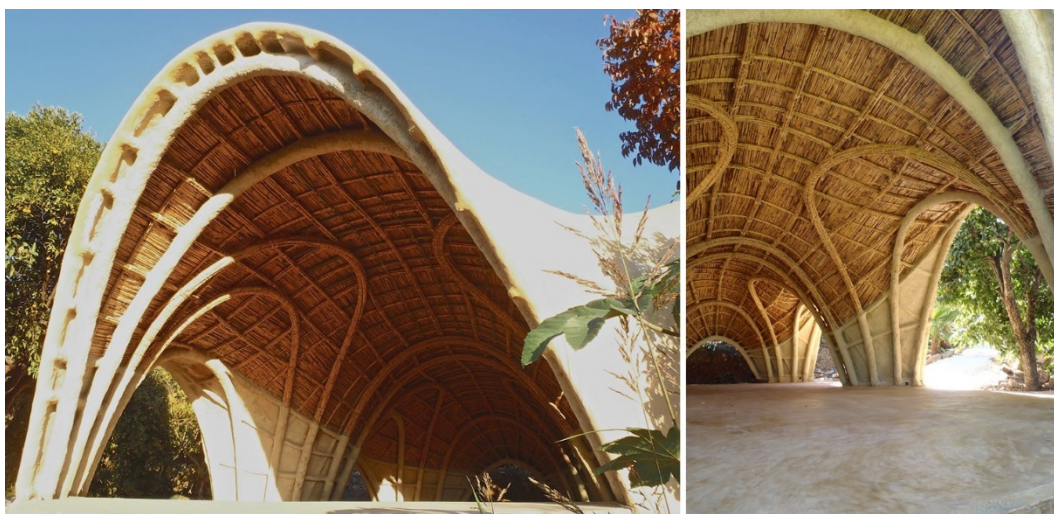
Figura 9: Casa de Laila , costruzione realizzata in Arundo Donax (CanyaViva, )
