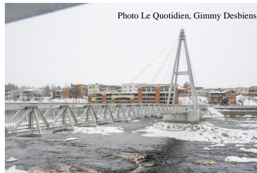
Figure 1.3 - Passerelle piétonnière en aluminium à Alma [7]
