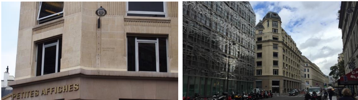
Fig. 8 : The existing site (2016)
