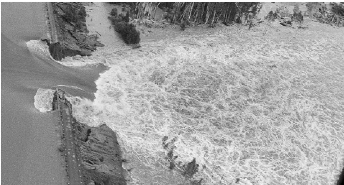
**Рисунок 2.** Прорыв грунтовой плотины Киселевского водохранилища. 14.06.1993.
