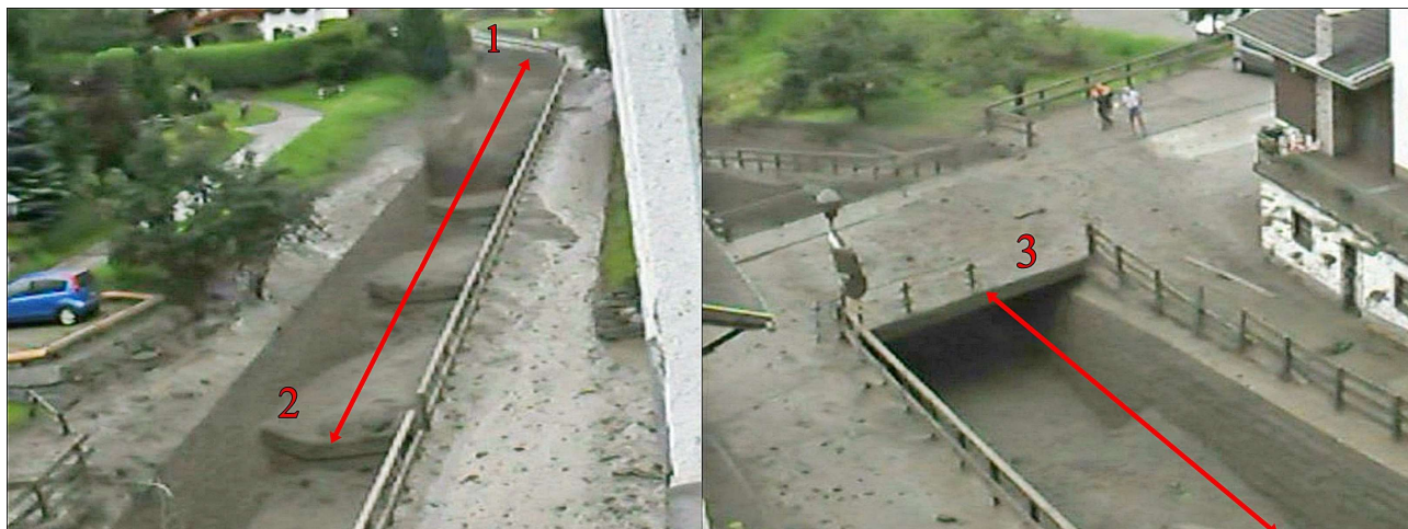
Рисунок 3. Схема участков прохождения селевого потока: 1 – ступень на повороте, 2 – ступень напротив парковки, 3 – мост.
